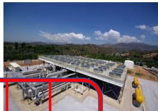
Plantas Binarias y eficientes Módulos de 12.5 MW (fabricar cien en México)
